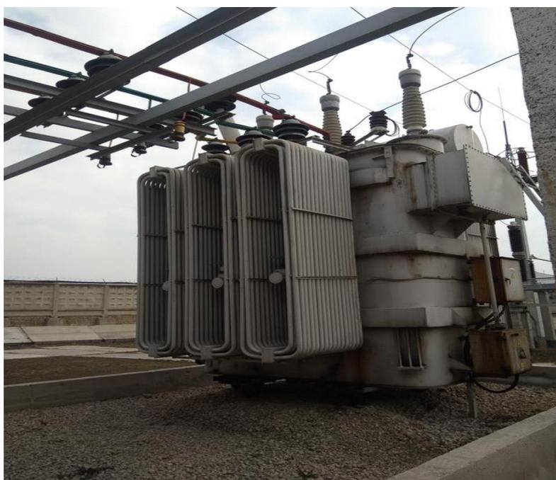
Рисунок 6 – Трансформатор ТДН-10000/35/10 кВ
