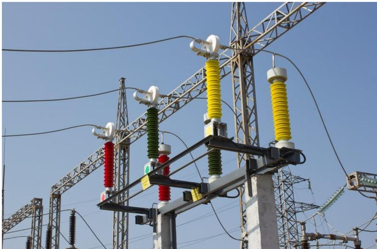
Рисунок 16 – Волоконно-оптические датчики тока и напряжения на опытном полигоне ОАО «НТЦ ФСК ЕЭС»
