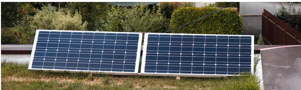
Рисунок 3- Пример небольшой солнечной электростанции на 3,1 кВт·ч/сутки
