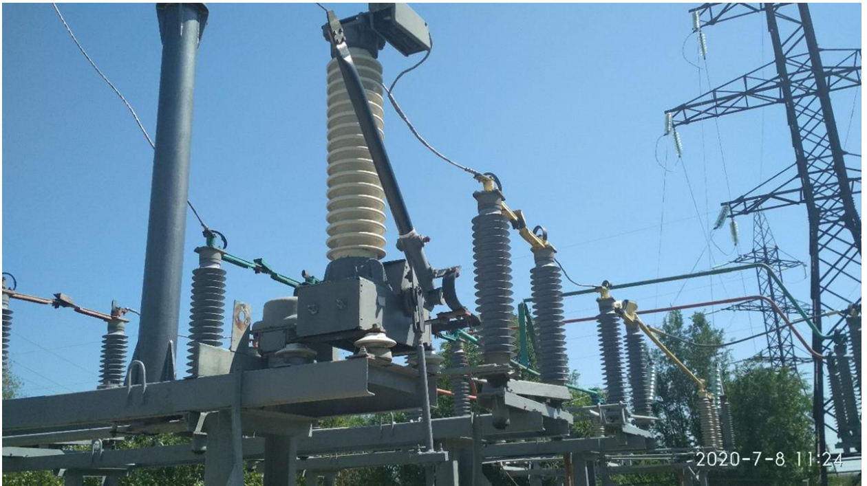
Рисунок 2 – КЗ-110 С1Т на ПС «Парфеновка»
