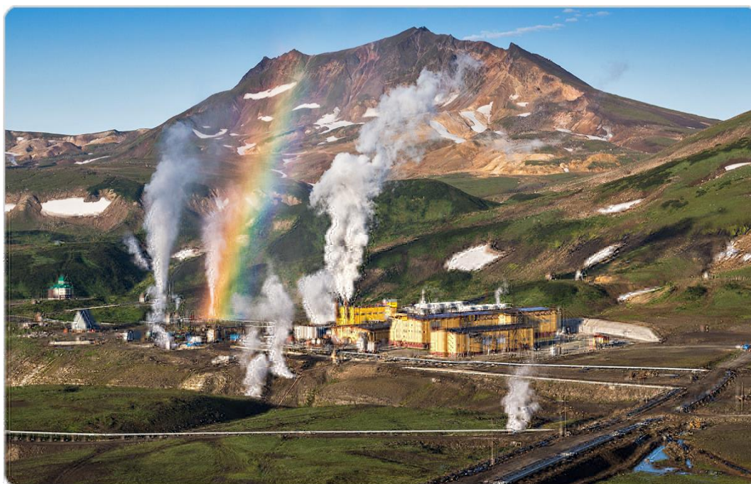
Рисунок 2 – Мутновская ГеоЭС (геотермальная электростанция)
