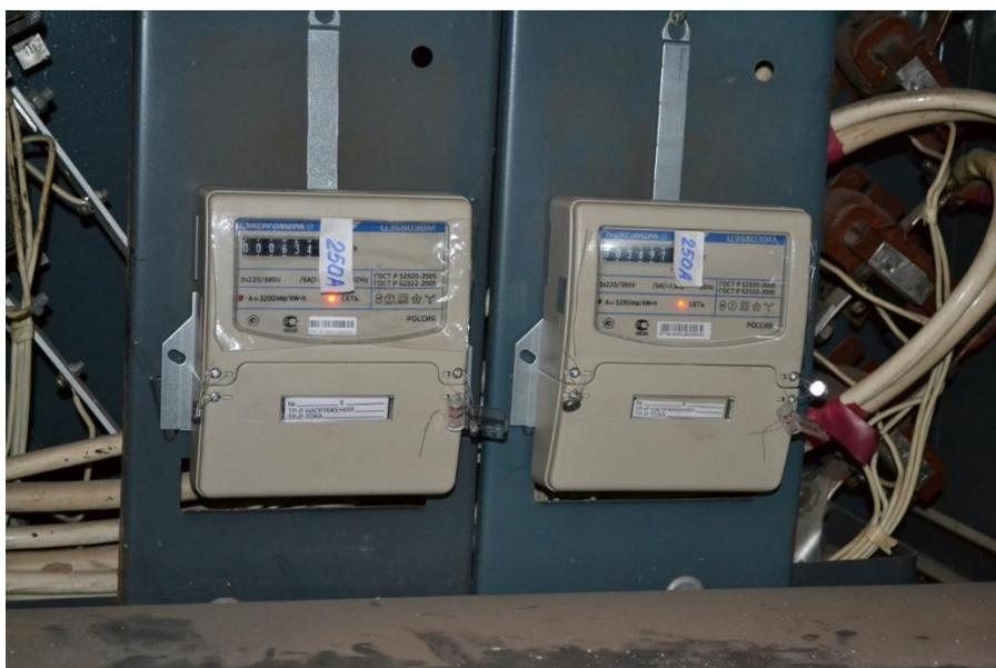
Рисунок 5 – Прибор коммерческого учета электрической энергии установленный в ВРУ-0,4 кВ Учебного корпуса №3 ул. Индустриальная 2а
