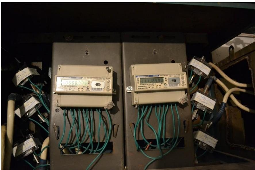
Рисунок 4 – Прибор коммерческого учета электрической энергии установленный в ВРУ-0,4 кВ Учебного корпуса №2 ул. Матросова
