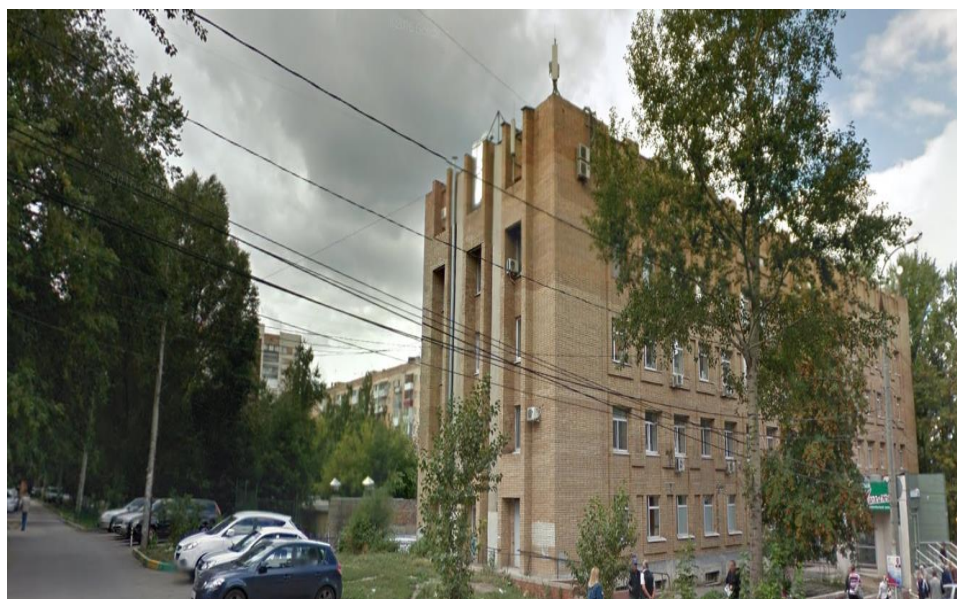
Рисунок 9 - Вид объекта со стороны пр. Ленина
