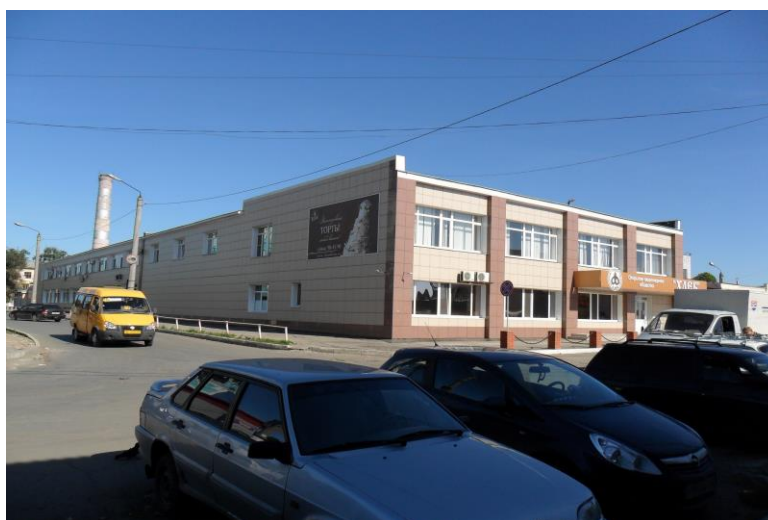
Рисунок 15 - Внешний вид АО «Хлеб» г. Сызрань со стороны ул. К. Маркса
