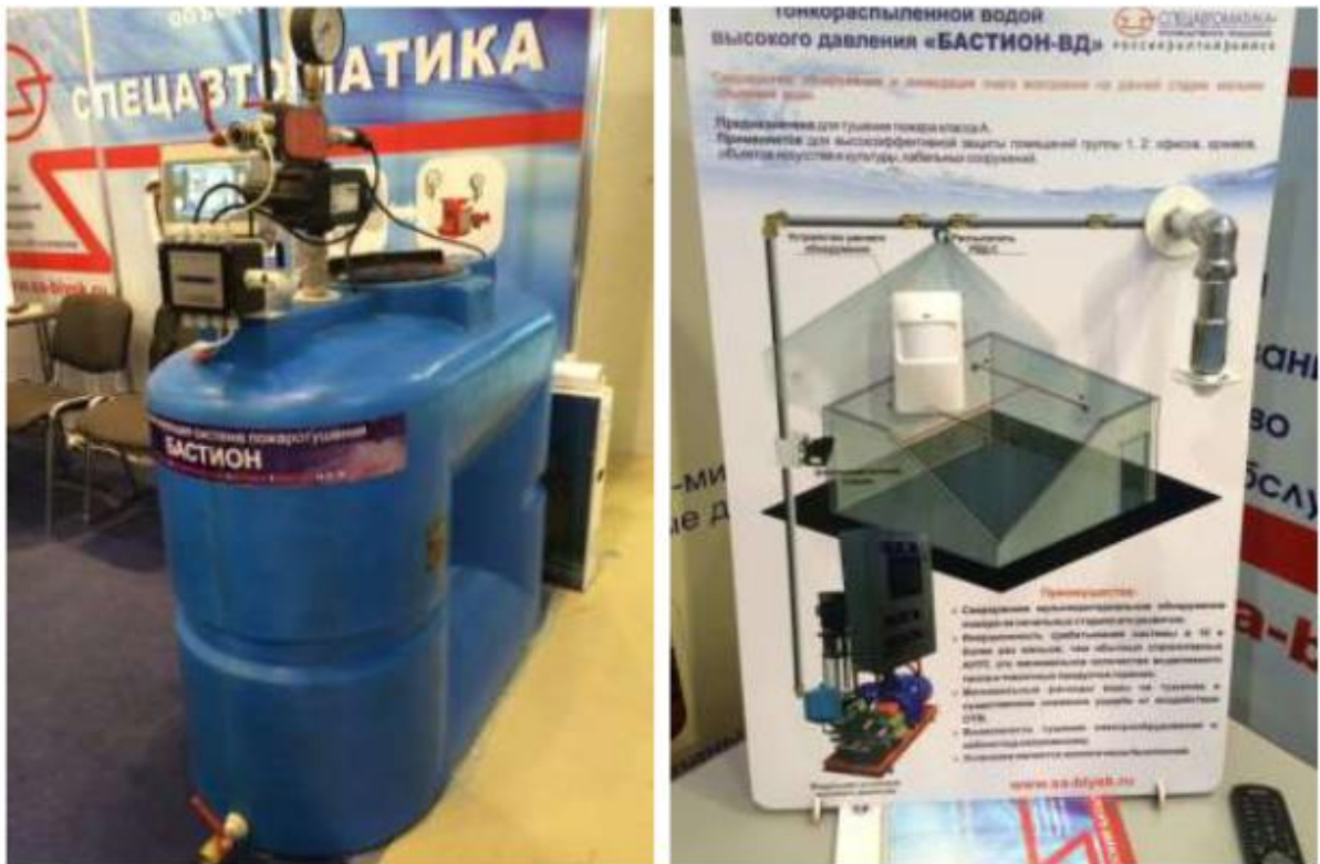
Рисунок 3 - Система пожаротушения «Бастيون»
