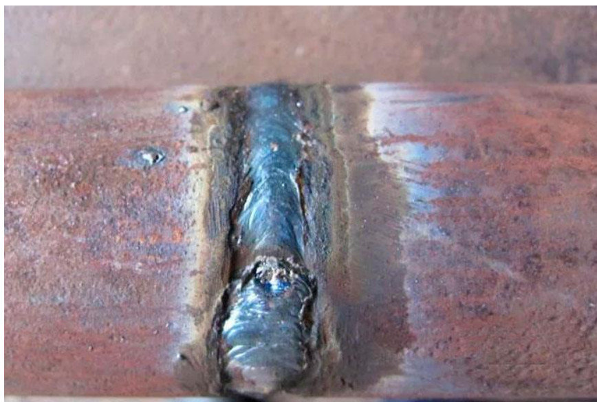
Рисунок 3 – Подрезы продольного шва при исправлении дефекта
