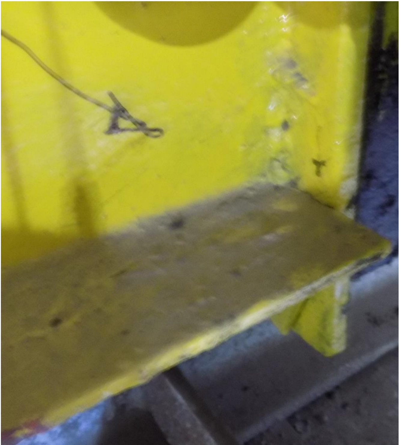
Рисунок 44 – Тавровое соединение элементов
