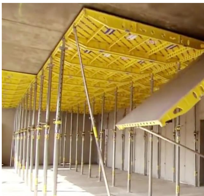
Рисунок 2.11 – Опалубка системы "ДОКА-FLEX для перекрытий
