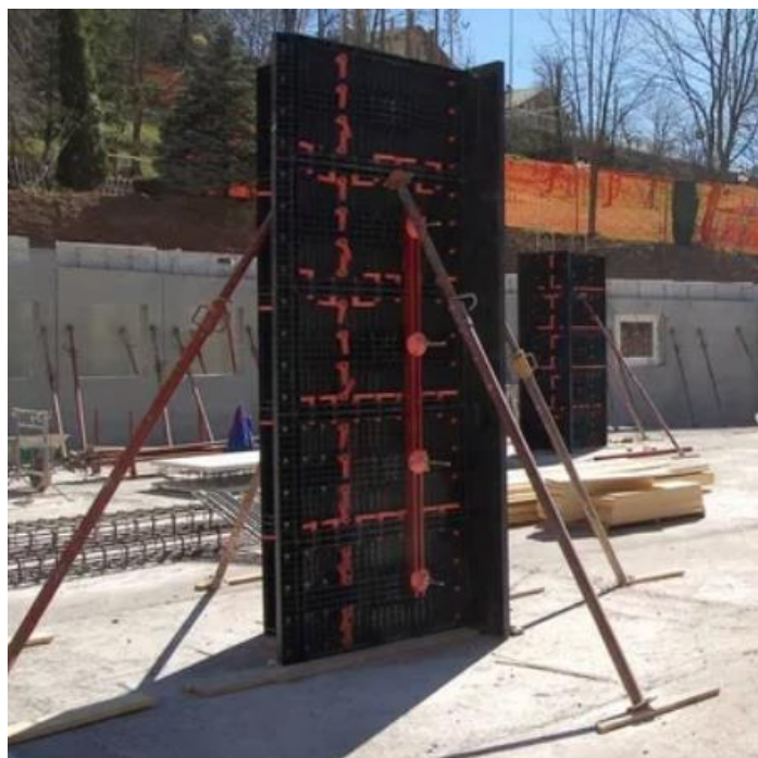
Рисунок 2.10 – Мелкощитовая опалубка системы "STAR-ТЕК" для колонн
