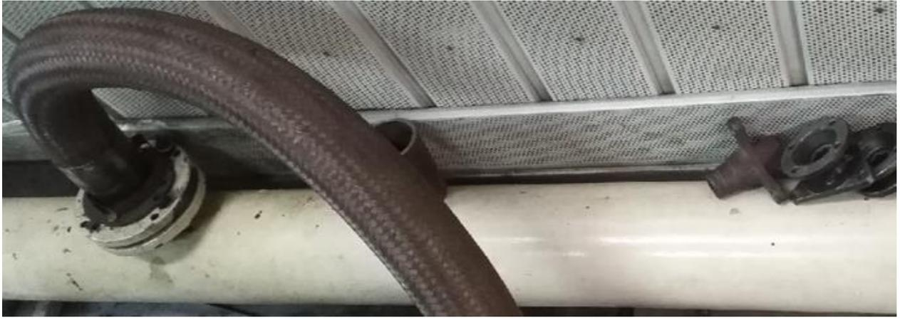
Рис 33 – Вентиляция для отвода отработавших газов
