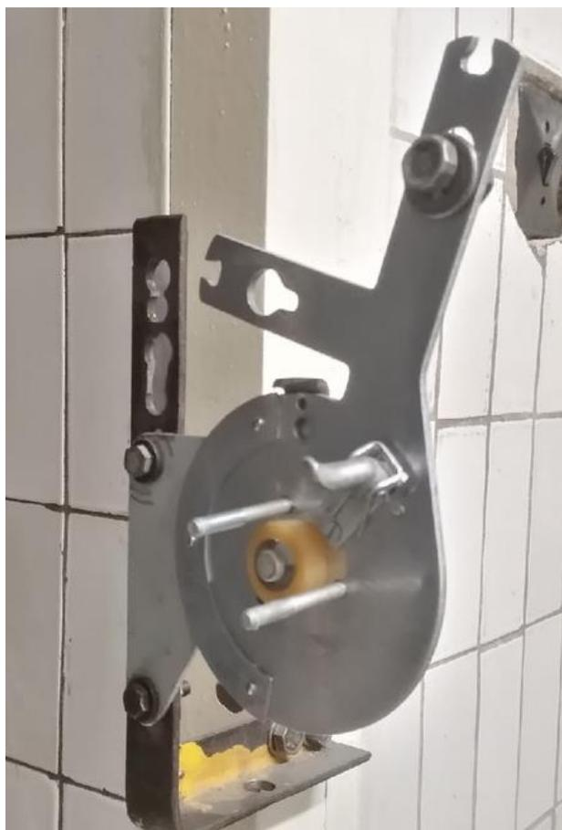
Рисунок 32 – Устройство для управления открытием дроссельной заслонки
