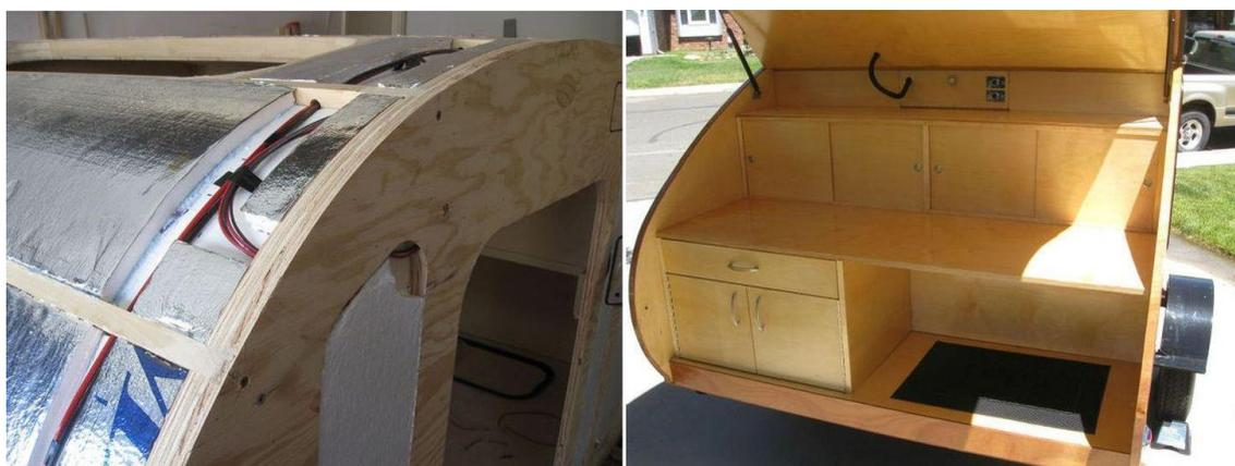
Рисунок 43– Размещение проводки и теплоизоляции в корпусе
