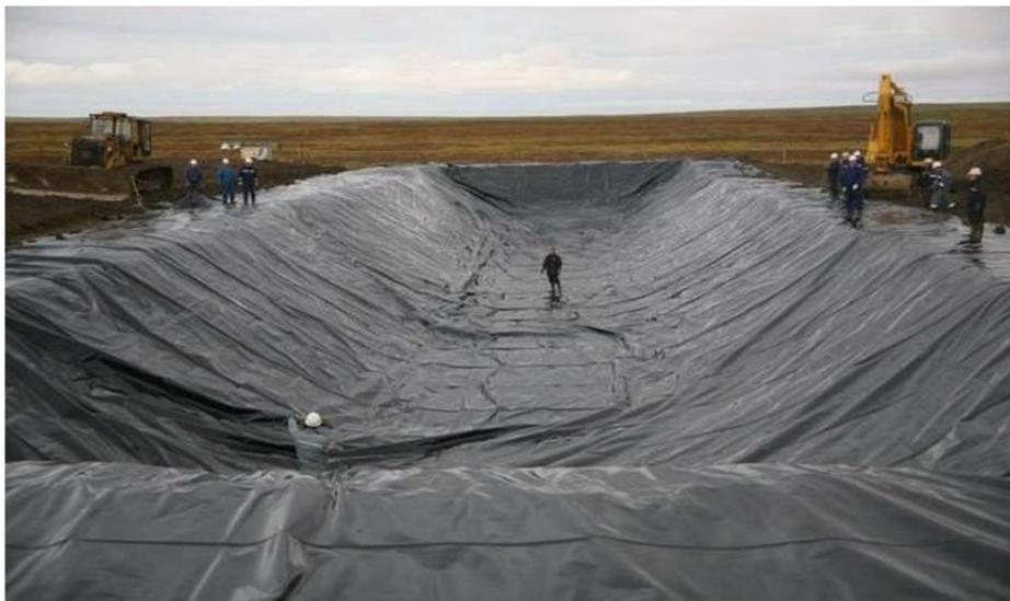
Рисунок 10 – Устройство защиты из геомембраны
