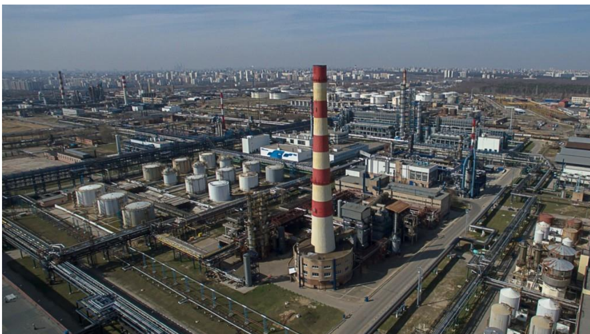
Рисунок 6 – Общий вид наземного резервуарного парка
