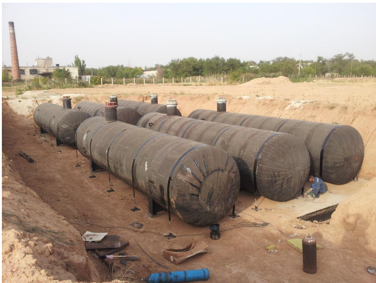
Рисунок 1 – Строительство подземного резервуарного парка
