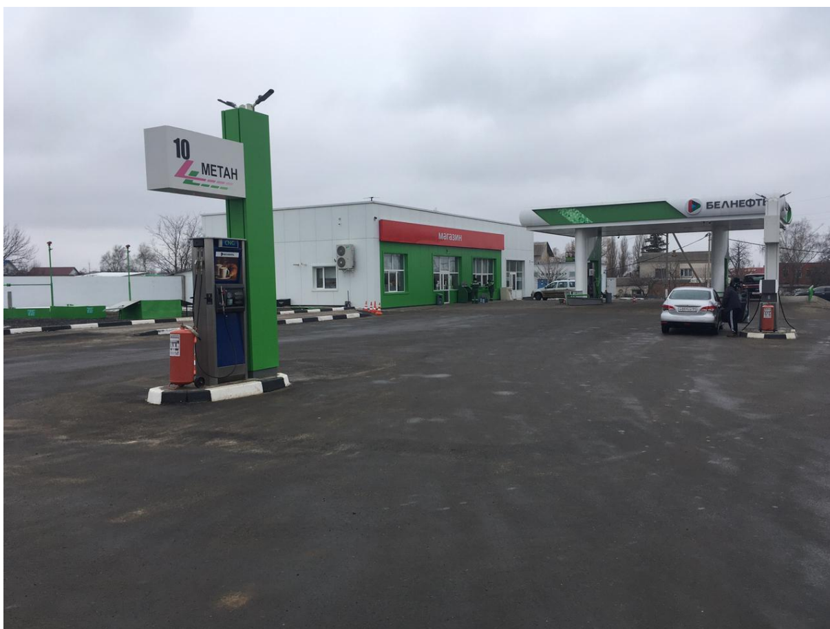
Рисунок 10 – Метановая газораздаточная колонка
