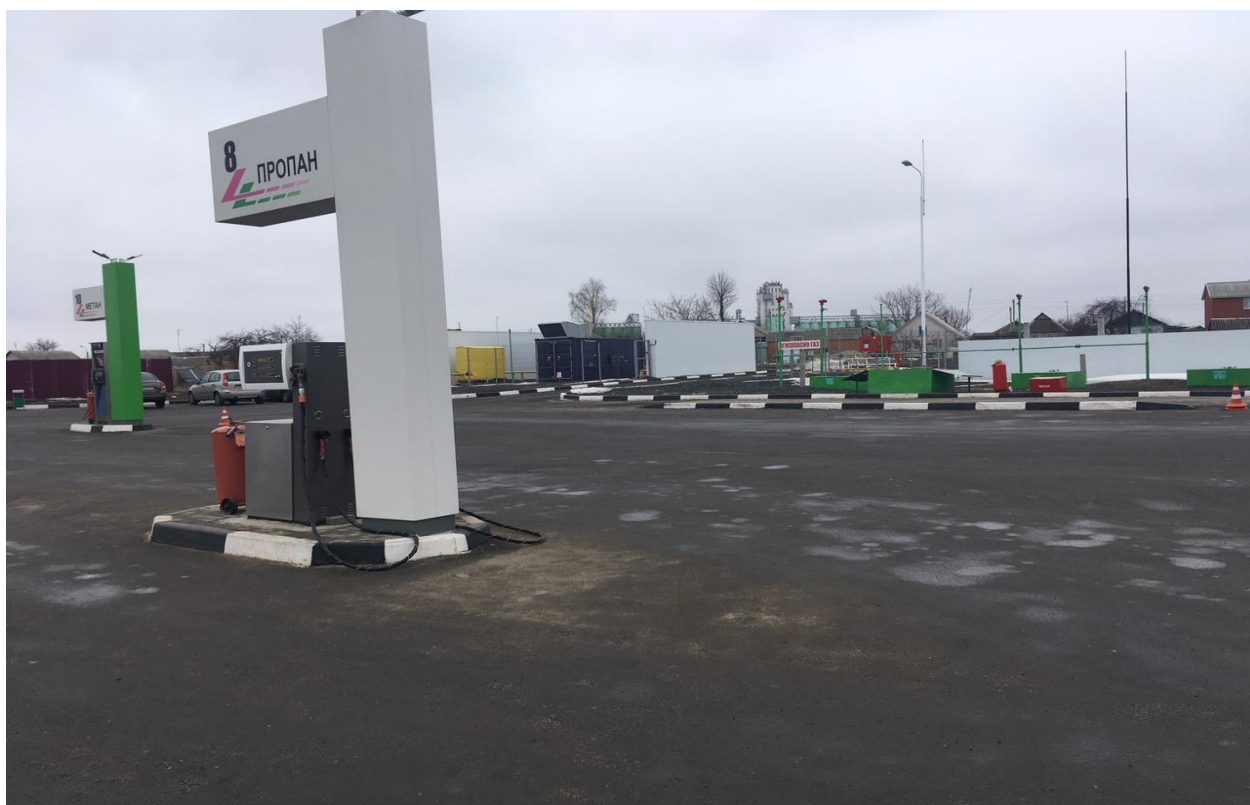
Рисунок 8 - Газораздаточная колонка Татсуно BMP 522/LPG
