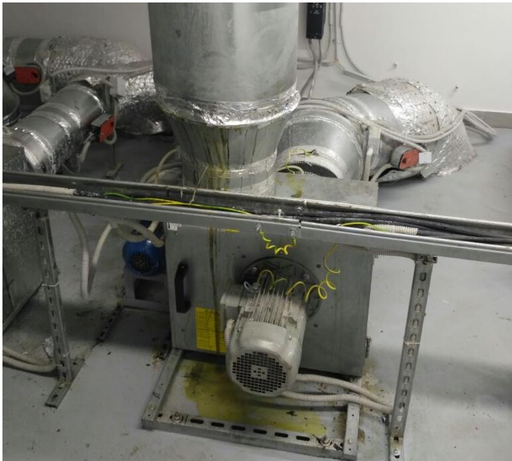
Рисунок 1 – Причина вспышки жировых отложений в вентиляции
