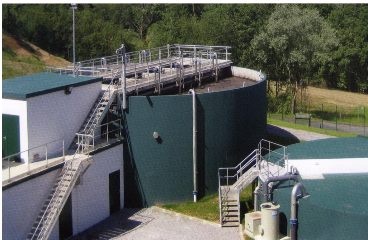
Рисунок 6 – Водоочистная станция с мембранным биореактором в Бассюсари, Франция
