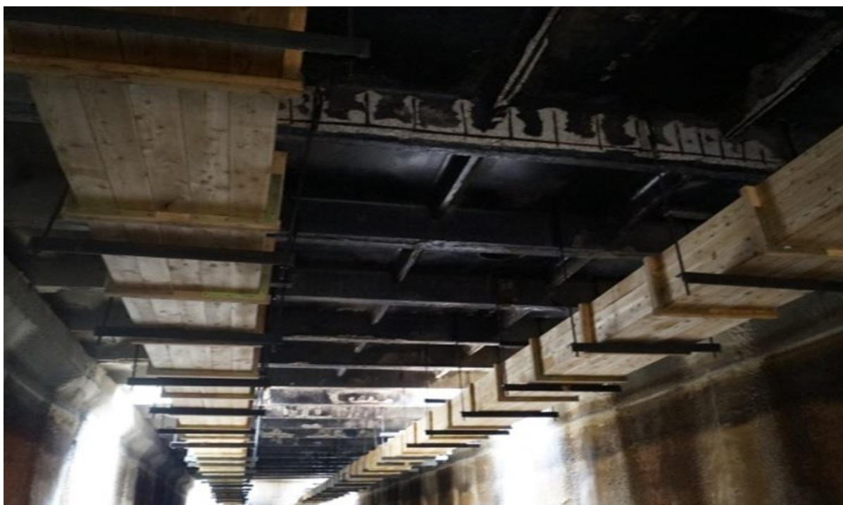
Рисунок 6 – Реконструкция и модернизация горизонтальных отстойников [6]
