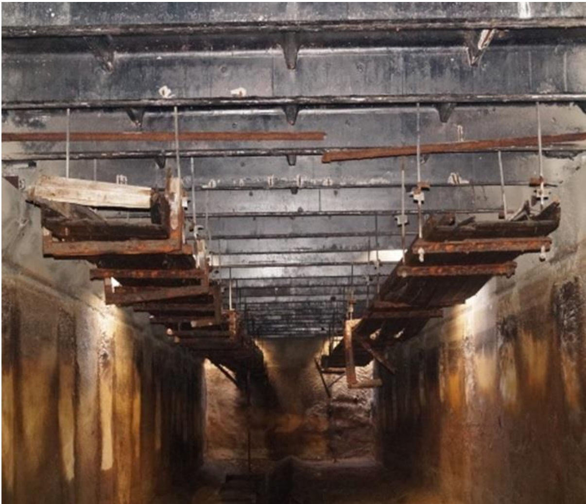
Рисунок 7 – Реконструкция и модернизация горизонтальных отстойников [6]
