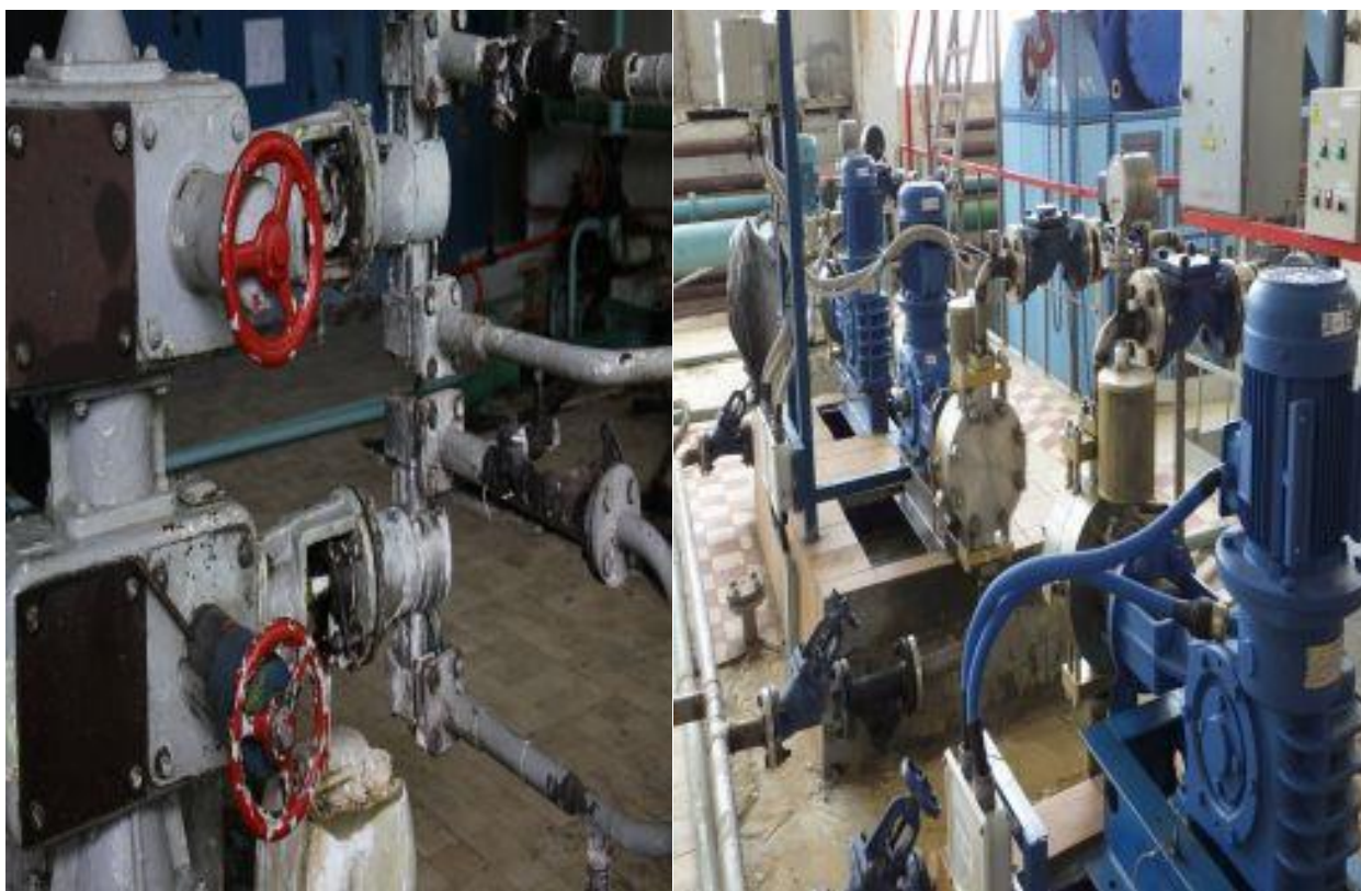
Рисунок 9 – Замена и модернизация дозировочного оборудования [6]
