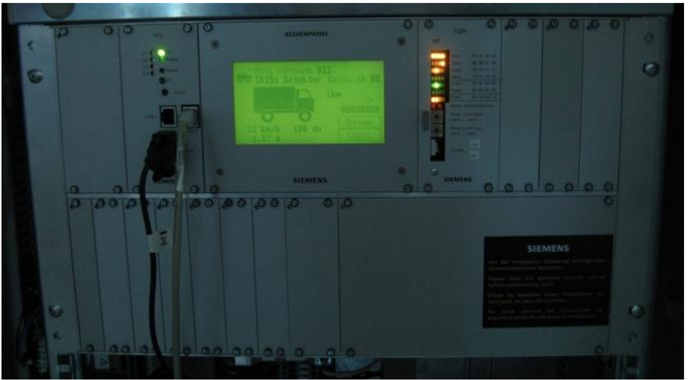
Рисунок 10 – Дорожный контроллер
