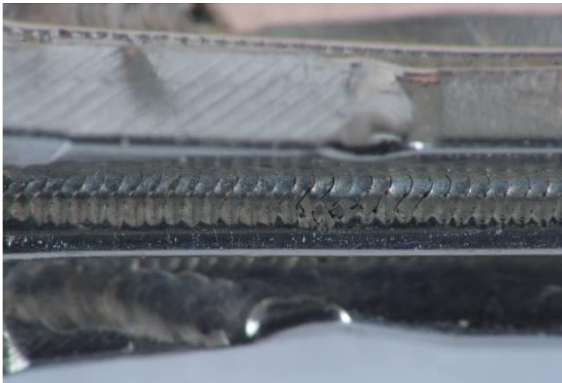
Рисунок 7.12 Внешний вид сварного шва трубки и ребер жесткости основной части оболочки
