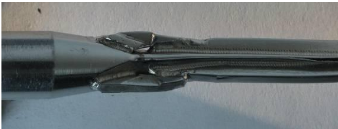
Рисунок 2.8 Внешний вид зоны сварного соединения основной и ниппельной частей
