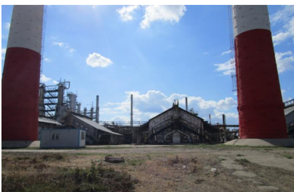
Рисунок 2.16 – Установка Л - 24/7. Источники № 0153 и №0154 – отдельно стоящие дымовые трубы
