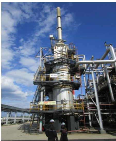
Рисунок 2.18 – Источник выброса ПГИ-ДИГ/280 №0528 – дымовая труба вертикальной печи
