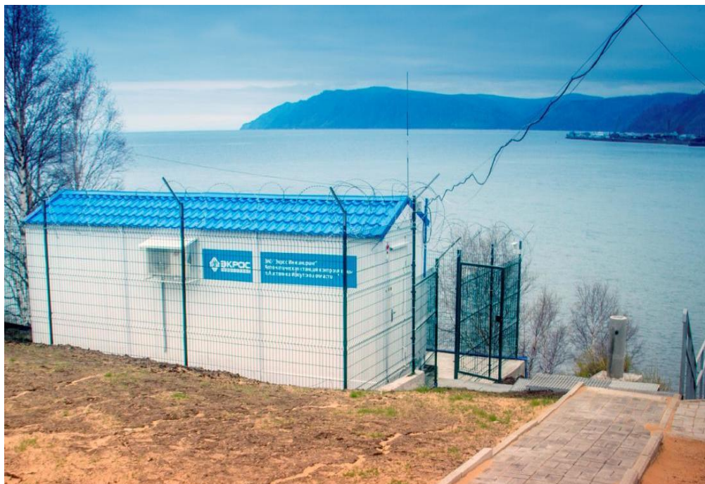
Рисунок 2.22 – Общий вид станции автоматизированной системы контроля качества сточных вод
