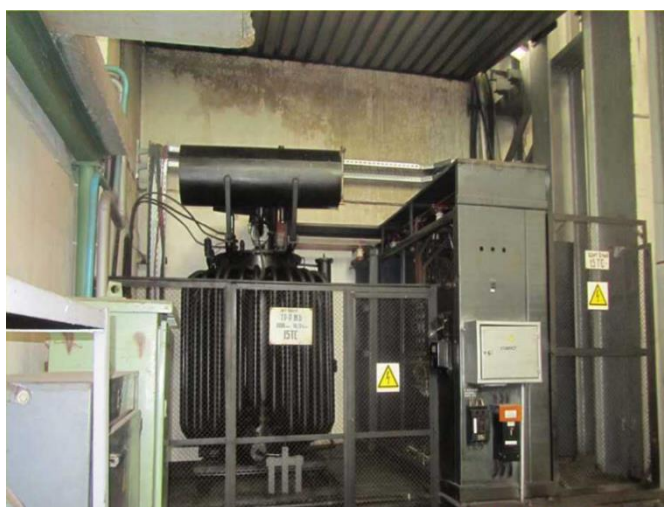
Рисунок 5 – Строительные конструкции трансформатора 15ТС ЖГЭС
