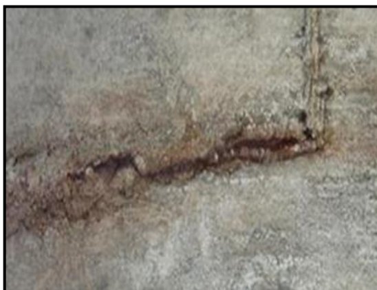
Рисунок 1.10 – Вид сварного шва на латке резервуара
