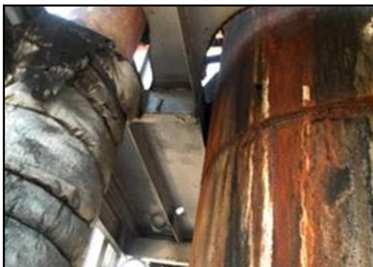
Рисунок 1.5 – Коррозия элементов реактора от течей рабочей среды и атмосферного конденсата
