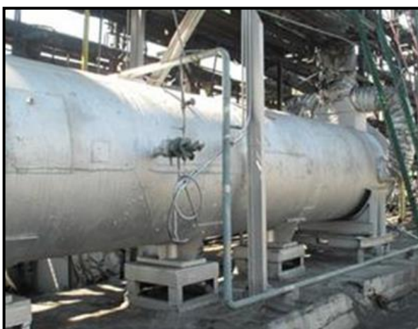
Рисунок 1.8 – Некорректное расположение сварных швов на штуцере и укрепляющем кольце
