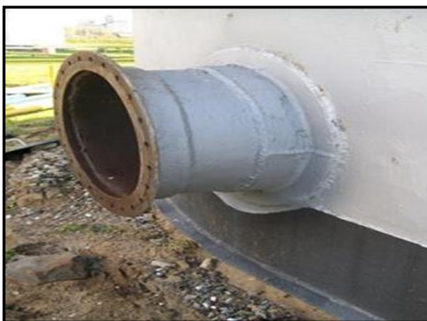
Рисунок 1.8 – Некорректное расположение сварных швов на штуцере и укрепляющем кольце
