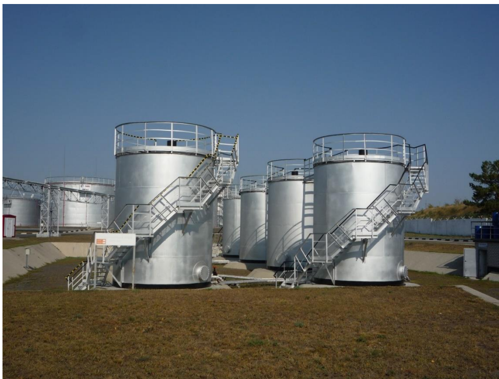
Рисунок 10 – Резервуарный склад нефтепродуктов
