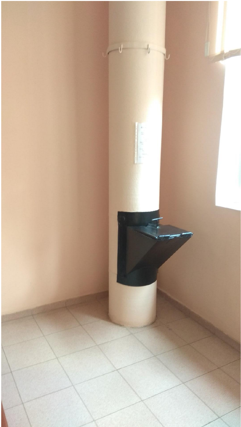
Рисунок 17 – Асбестовый мусоропровод с обычным загрузочным клапаном
