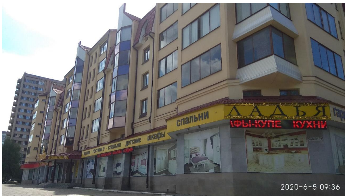
Рисунок 1 – Жилой дом на Приморский бульвар, д.15
