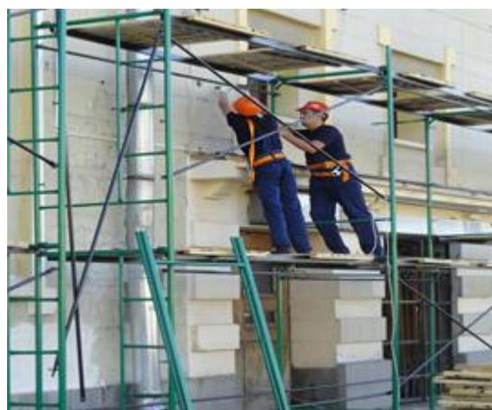
Рисунок 12 – Производство теплоизоляционных работ с применением лесов
