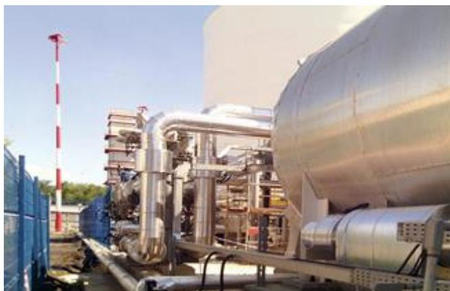
Рисунок 8 – Теплоизолированный трубопровод и емкость
