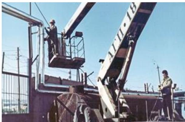
Рисунок 11 – Производство теплоизоляционных работ с применением автогидроподъемника
