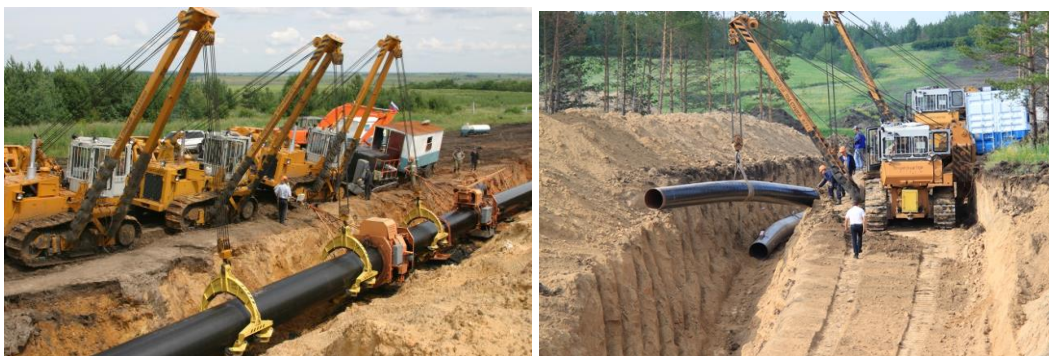
Рисунок 1.1 – Строительство магистрального газопровода
