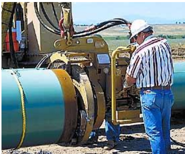
Рисунок 2.5 – Подготовка кромок труб с использованием станка PFM 3456
