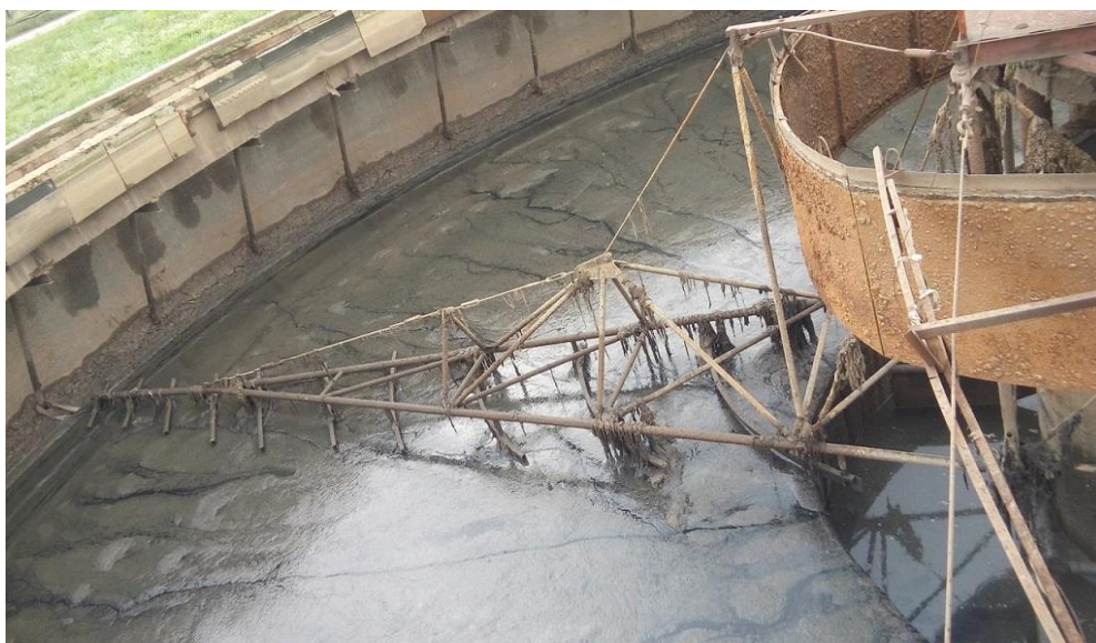
Рисунок 6 - Загрязненный илоскреб первичного отстойника
