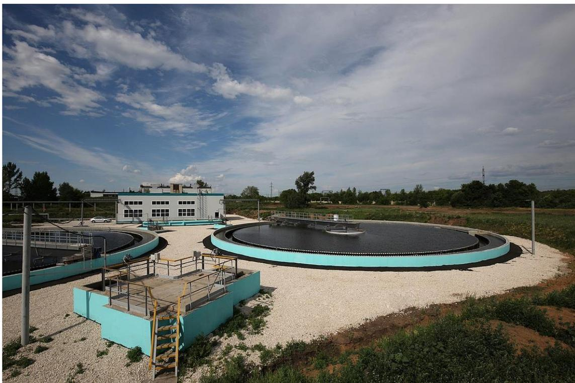
Рисунок 5 – Новые вторичные отстойники и здание иловой насосной, построенные в результате реализации первого этапа реконструкции очистных сооружения ООО «Тольяттикаучук» [19]
