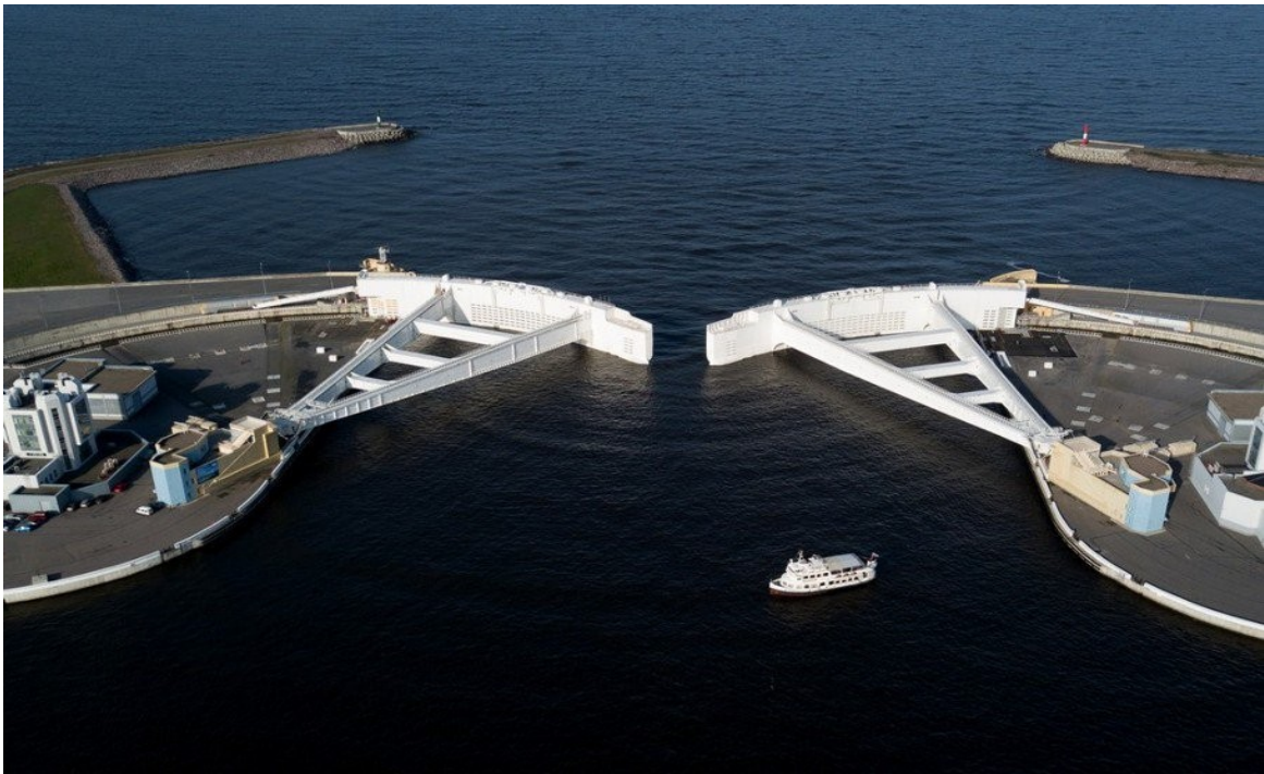
Рисунок 6 - Закрытие судопропускного канала С1
