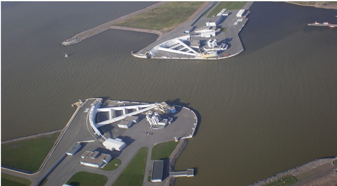
Рисунок 5 - Судопропускное сооружение С1(вид сверху)
