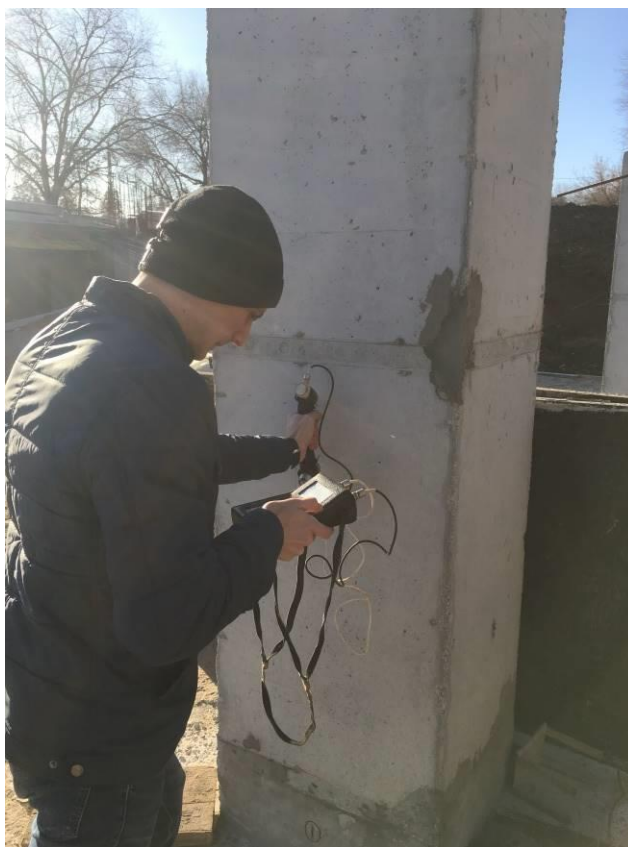
Рисунок 3.2 – Проведение испытаний косвенным методом с помощью ультразвукового прибора Пульсар-1
