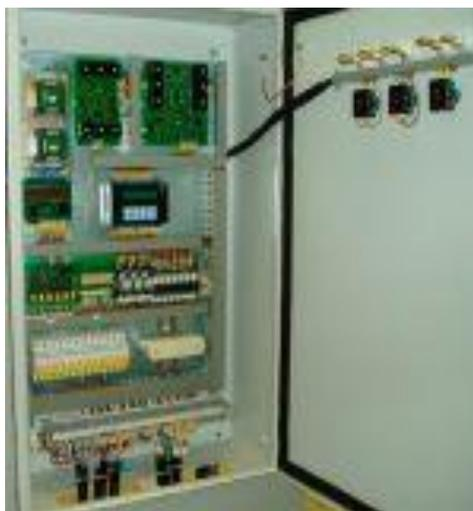
Рисунок 17 – Шкаф управления с электронной (тиристорной) системой АВР
