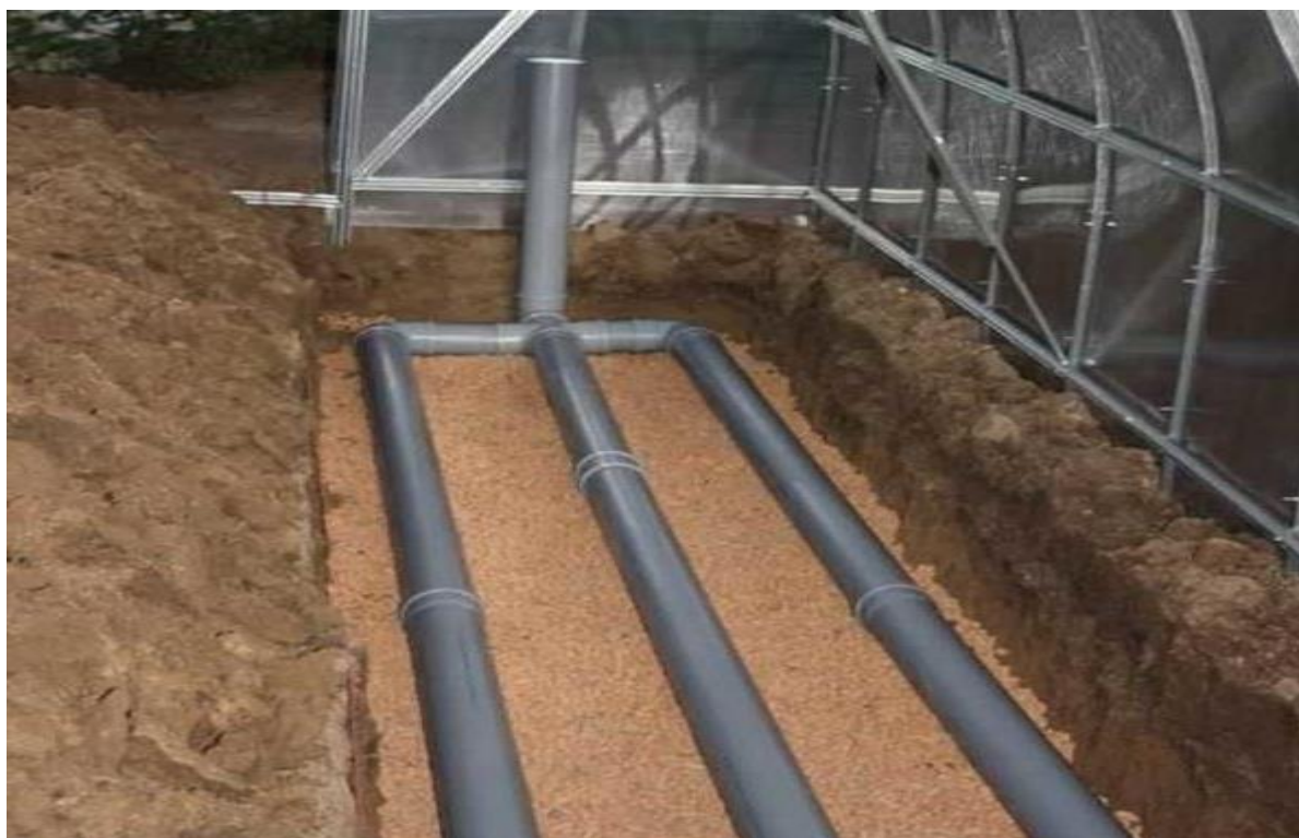
Рисунок 5.20 – Способ подогрева теплицы с помощью теплого воздуха
