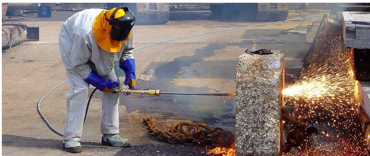
Рисунок 2.2 – Резка железобетона на заводе ЖБИ в Шлюзовом
