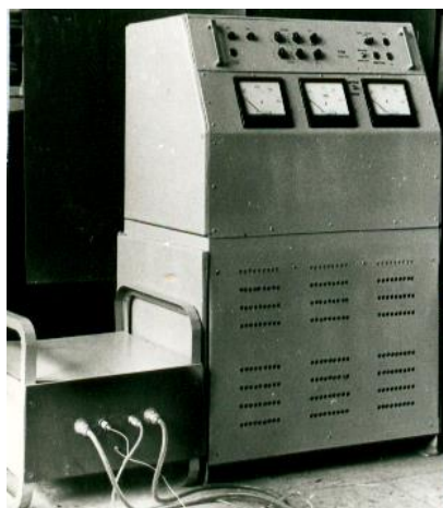
Рисунок 2.3 – Источник питания для трёхфазной сварки алюминиевых деталей
