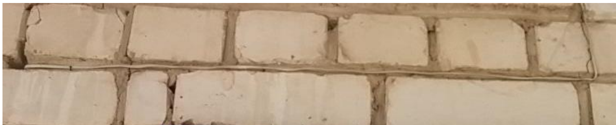
Рисунок 4 –Наружная стена корпуса
