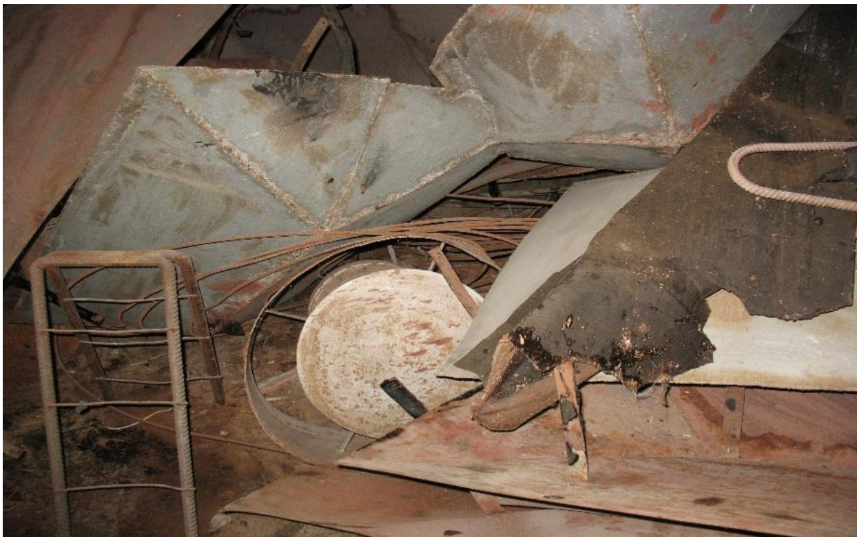
Рисунок 8 – Нефункциональные дефлекторы
