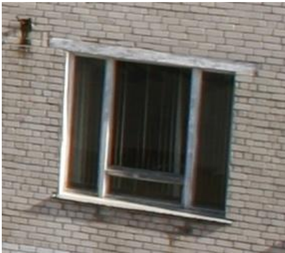
Рисунок 5 –Старое створчатое окно с деревянной рамой
