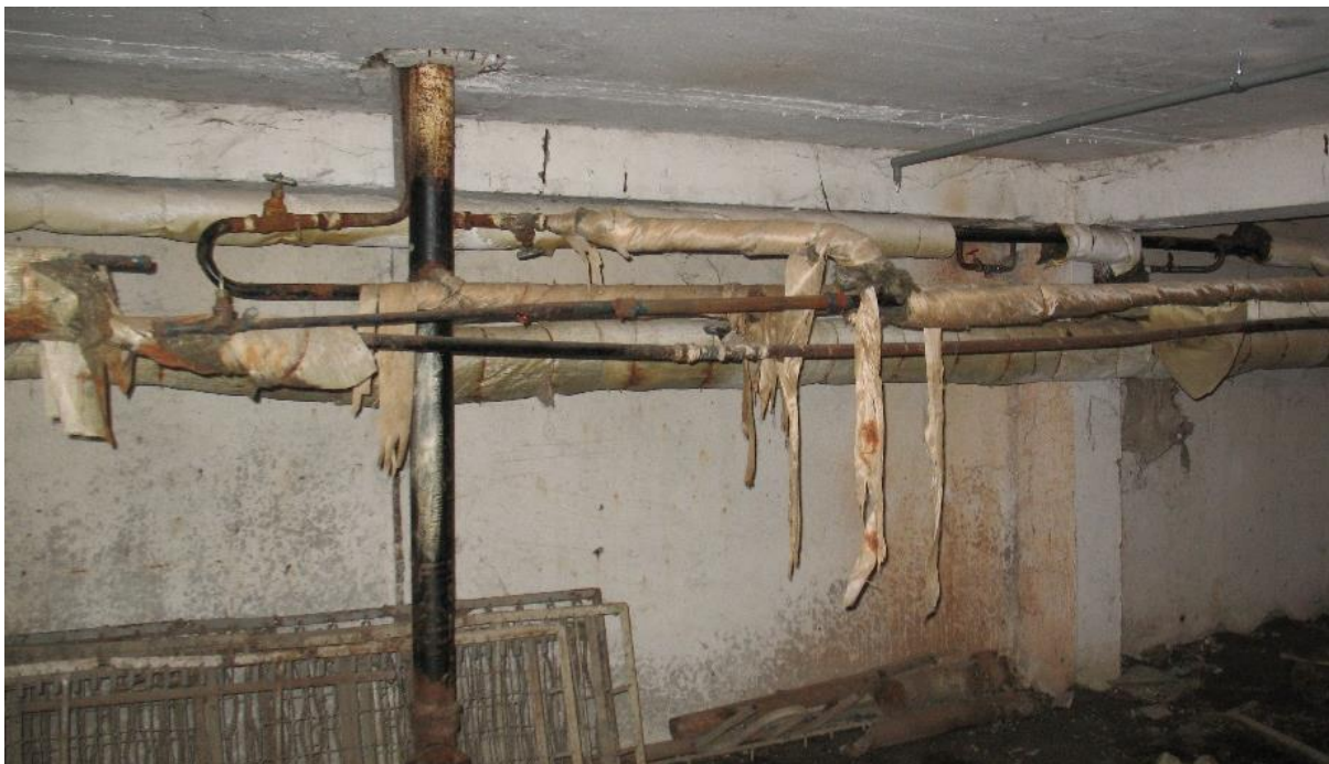
Рисунок 13 –Разветвление магистральных линий отопления
