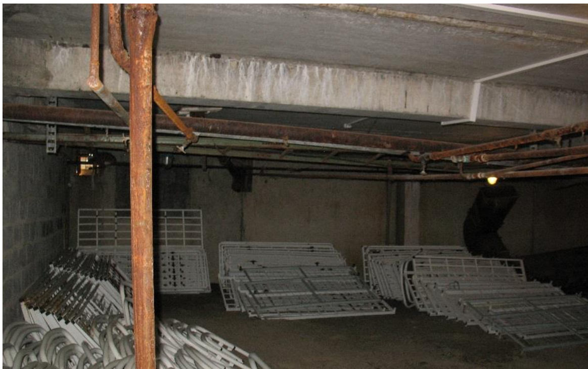
Рисунок 14 – Прокладка магистральных линий отопления
