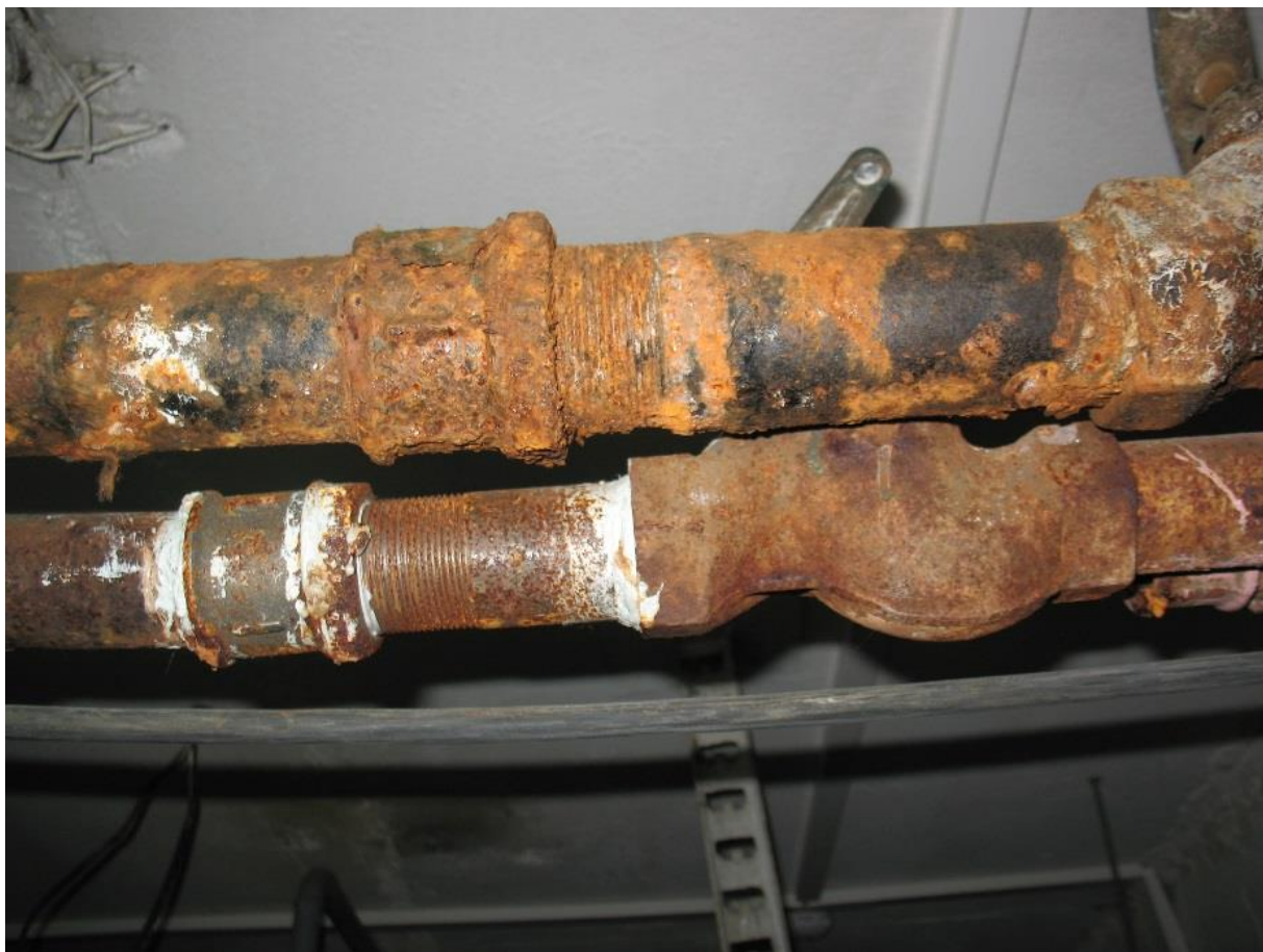
Рисунок 20 – Коррозия трубопроводов
