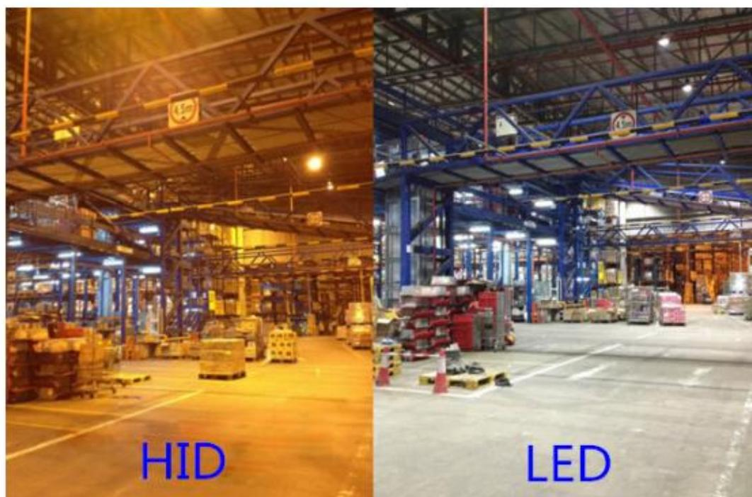
Рисунок 1.2 – Цветопередача газоразрядных ламп и СД светильников
