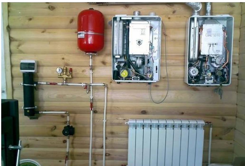
Рисунок 17 – Водяное отопление с электрическим котлом
