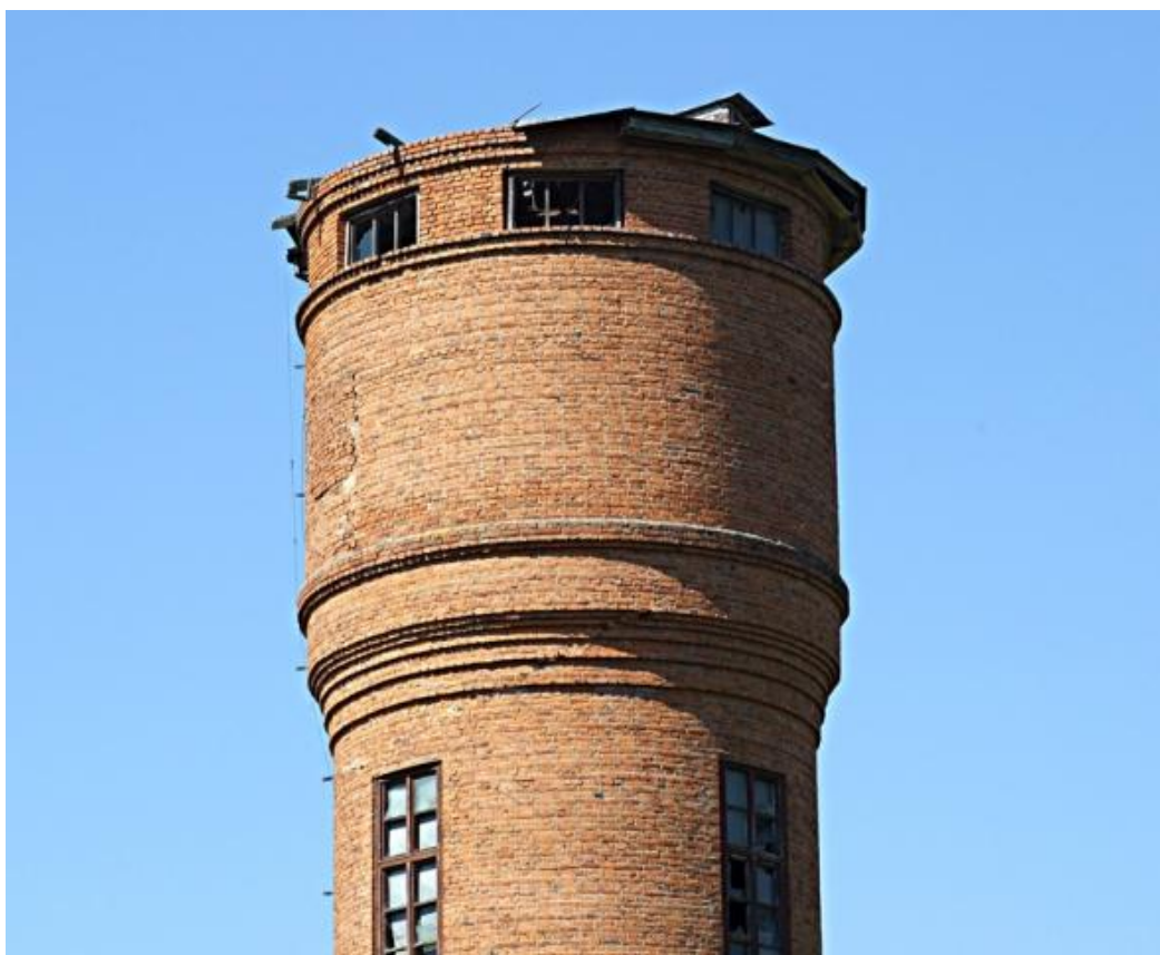
Рисунок 1.9 – Приемный бак водонапорной башни
