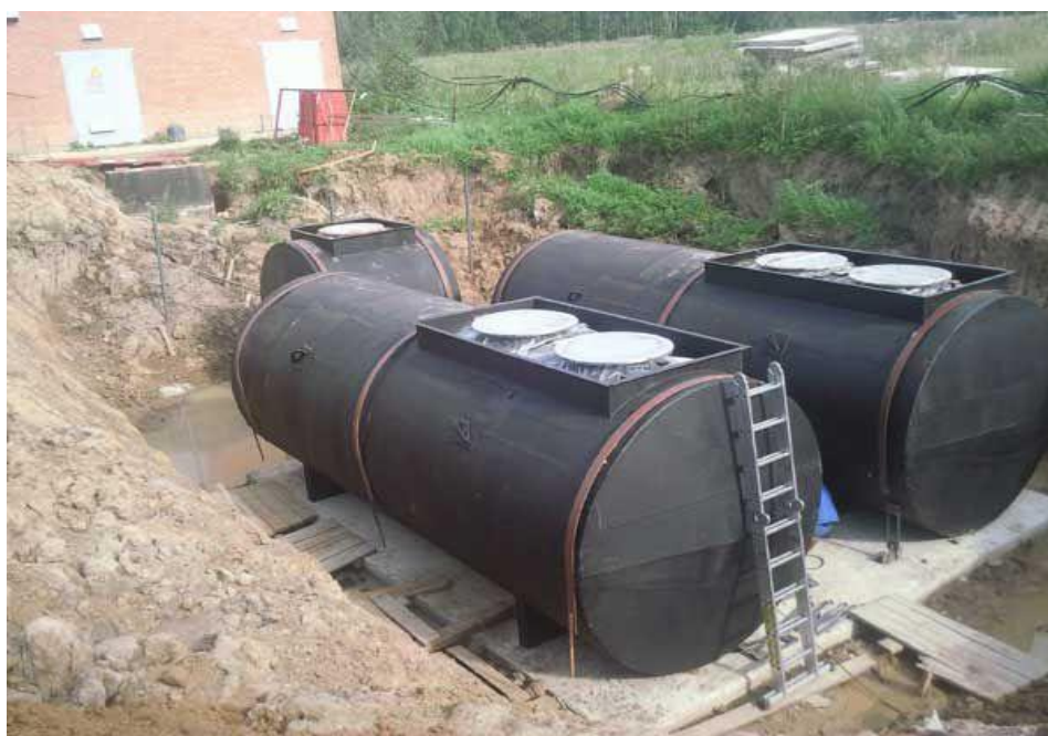
Рисунок 1.8 – Подземные пожарные резервуары
