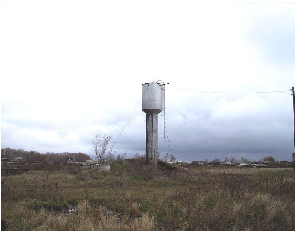
Рисунок 1.10 – «Водонапорная башня системы Рожновского»
