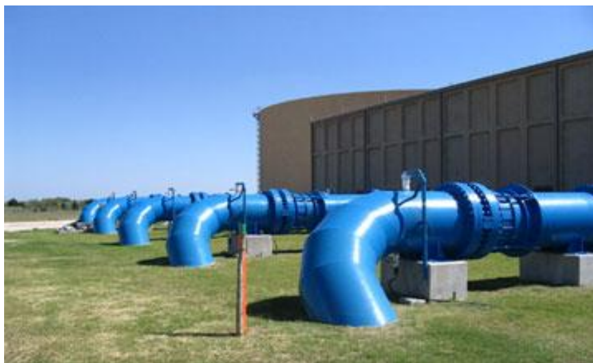
Рисунок 2.1 – Насосная станция с магистральными водопроводами
