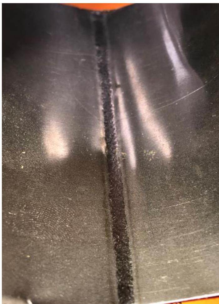
Рисунок 69 – Формирование корня шва с помощью штанги
