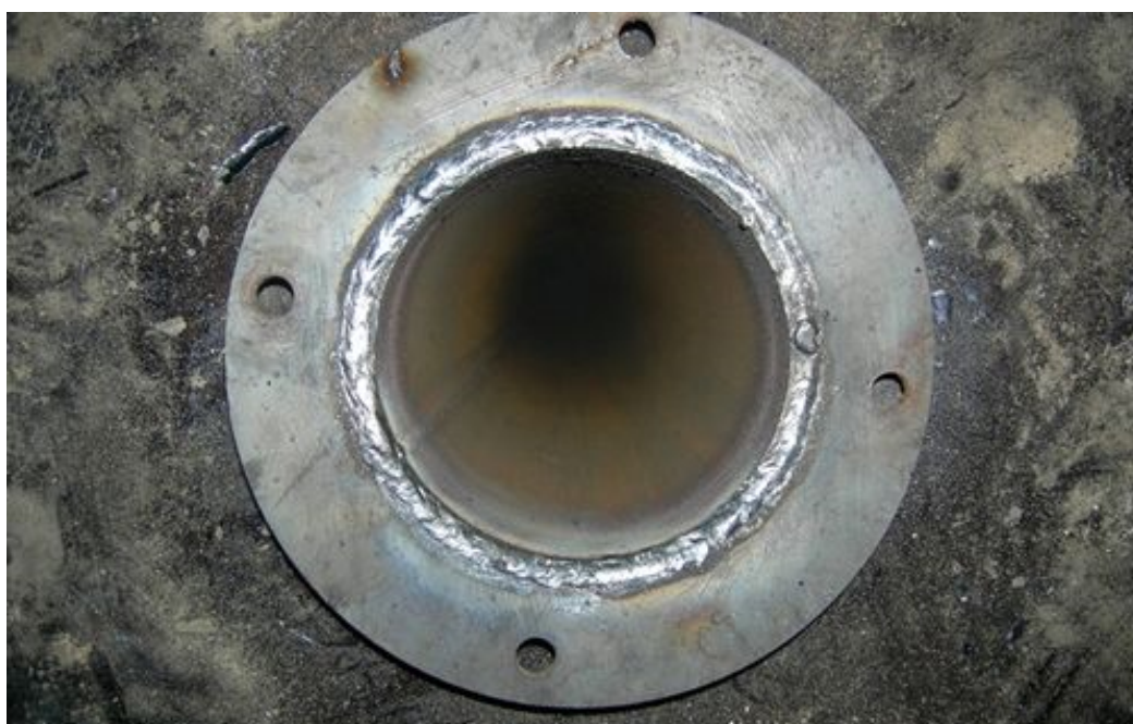
Рисунок 8.9 – Сварка трубы и плоского фланца (внутренний шов)
