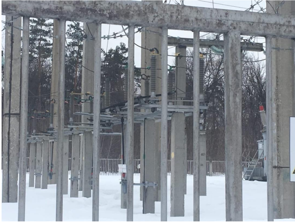
Рисунок 2 – Фото разъединителя
