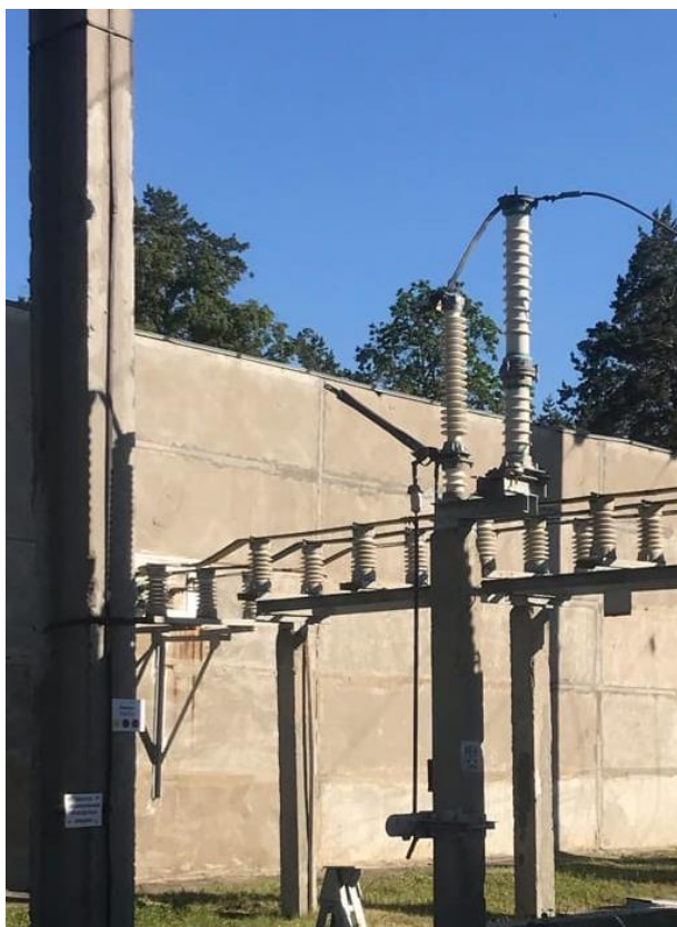
Рисунок 48 – Фото заземлителя
