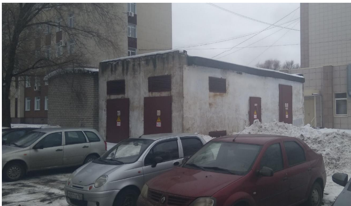
Рисунок 3 – Общий вид ТП-2 с улицы
