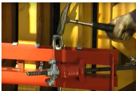
Рисунок 3.2.5 – Соединение частей опалубки тяжем
