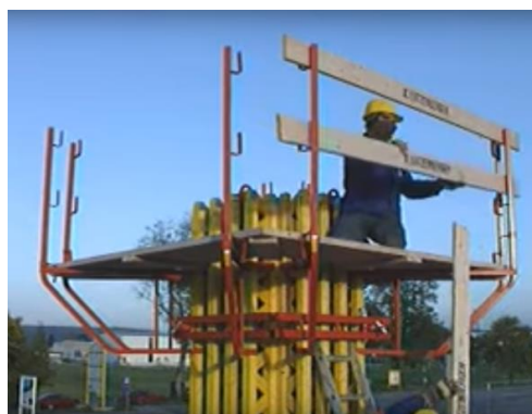
Рисунок 3.2.7 – Устройство консольных подмостей
