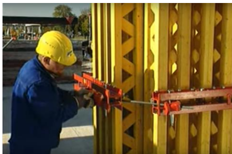
Рисунок 3.2.4 – Соединение частей опалубки тяжем
