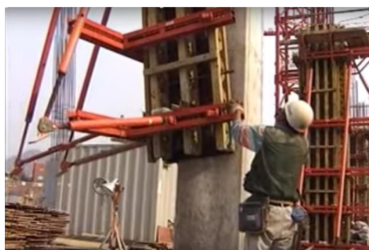
Рисунок 3.2.9 – Распалубка колонн
