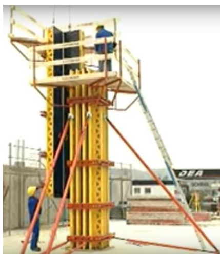
Рисунок 3.2.8 – Демонтаж опалубки
