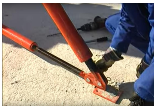
Рисунок 3.2.6 – Крепление подкосов
