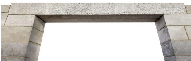
Рисунок 2– Газобетонная перемычка
