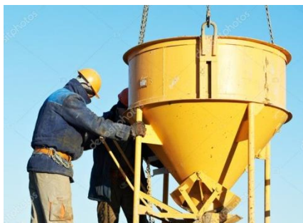
Рисунок 3.16 – Подача бетонной смеси к месту укладки стреловым самоходным краном с бункером
