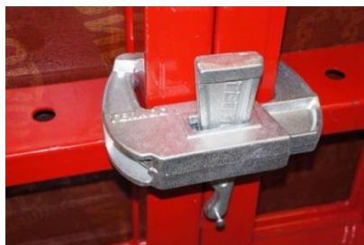
Рисунок 3.8 – закрепление щитов опалубки с помощью прижимных скоб
