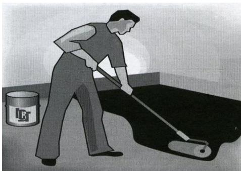
Рисунок 3.1 – Нанесение огрунтовки битумным праймером
