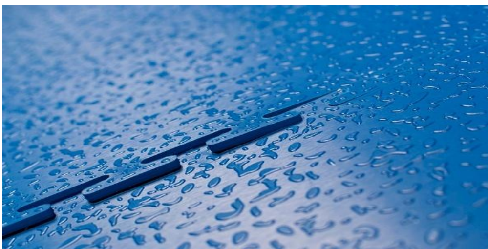
Рисунок 4 – Фото напольного покрытия
