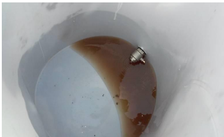
Рисунок 3.16 – Начало работы водозаборного сооружения
