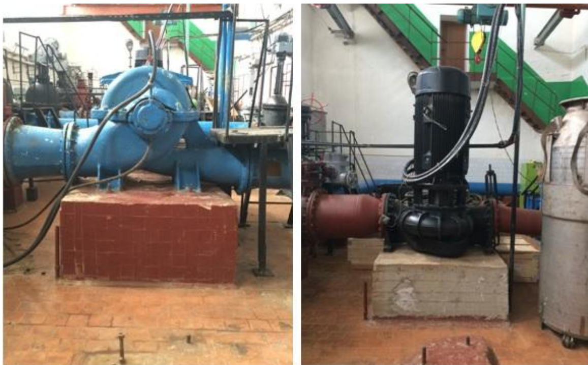
Рисунок 2.4 - Замена центробежных насосов (слева: до реконструкции; справа: после реконструкции)
